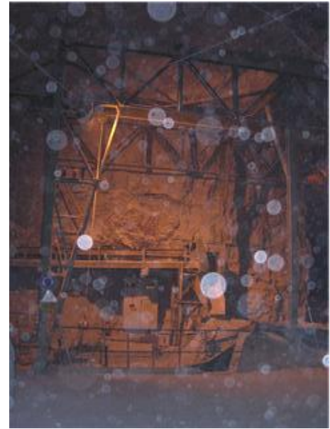
Autres installations présentes dans les galeries
