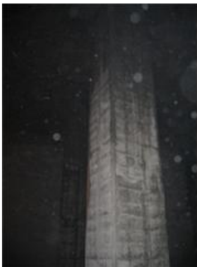
Pilier de soutènement
