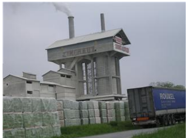
Le four à chaux (vu de l'extérieur)
