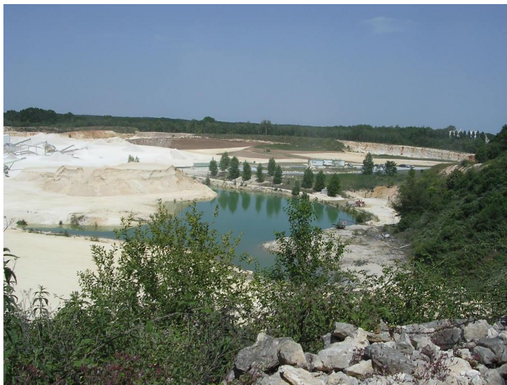
Vue d'ensemble du site d'exploitation
