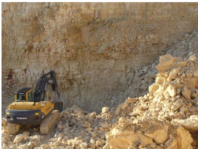
Pelleteuse au niveau du front de taille
