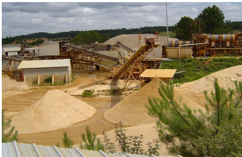
Vue générale des installations
