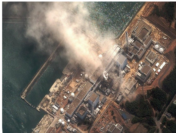
Vue de dessus de la centrale pendant l'accident.
