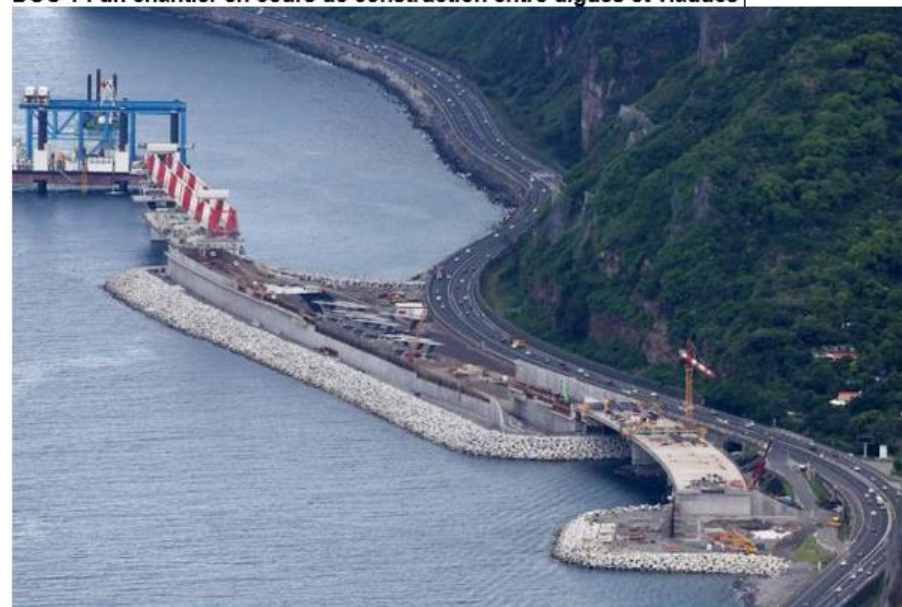
DOC 1 : un chantier en cours de construction entre digues et viaducs |
